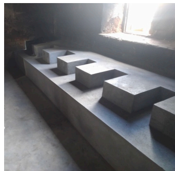
Création d'un espace de cuisson pour préparer les repas des cantines.
